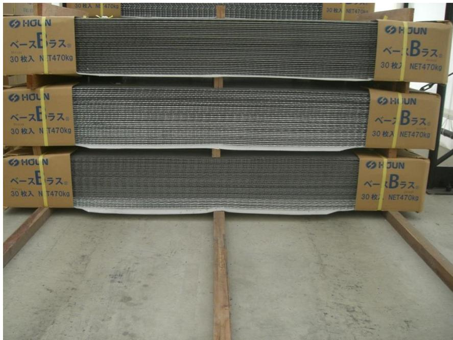
ベース B ラス積み込み状況 (現場保管も同様に 3 段積み)
