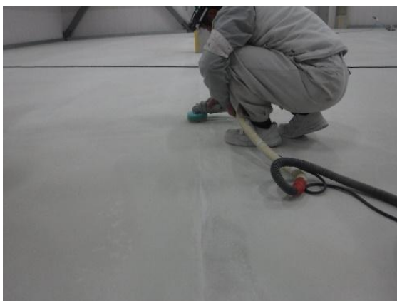
⑪打ち継ぎ部分補修
