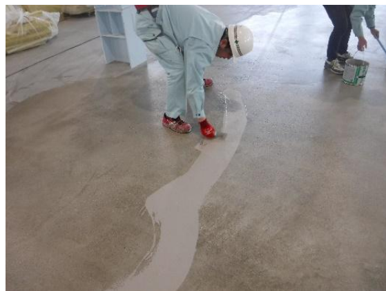
②クラック・不陸などの補修
