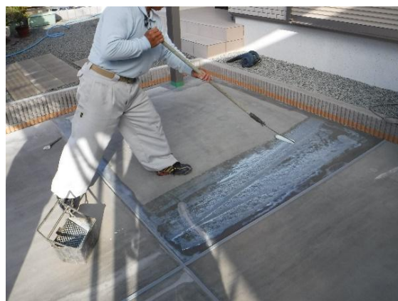
④吸水調整材の塗布 2
