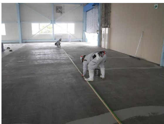
⑤堰板の設置
