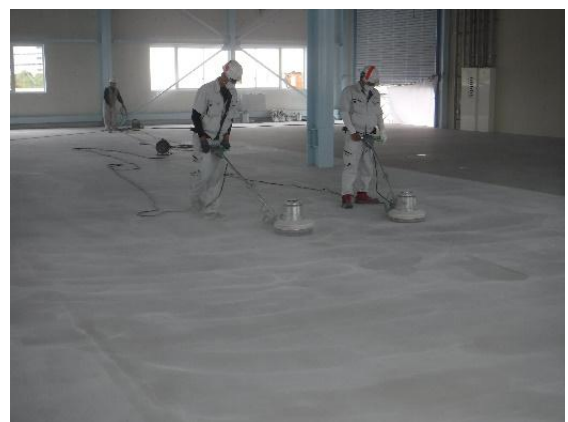
⑫ポリッシャーによる補修
