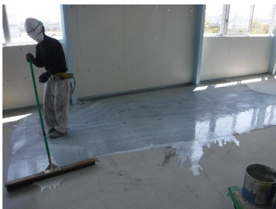
③吸水調整材の塗布 1
