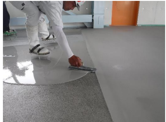
⑩コテ均し（打ち継ぎ部分）
