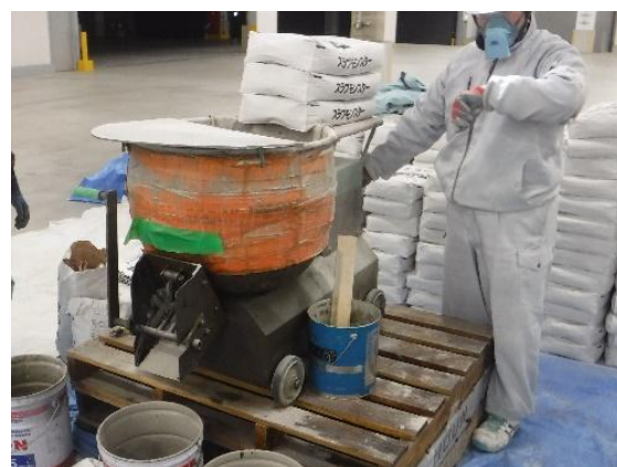
⑥練混ぜ（グラウトミキサー）
