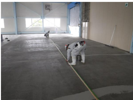
⑤堰板の設置
